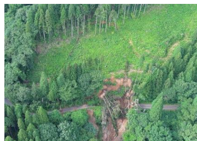
ドローンを活用した被災状況調査 (金木支署：青森県中泊町)
