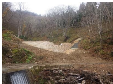
土砂流出対策 (溪間工) (岩手南部署：岩手県西和賀町)
