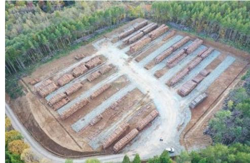
トレーラーへの効率的積込や丸太の大量保管ができるストックヤード
