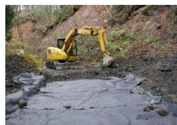
東北式シート工法 (軸掘れ軽減対策)
