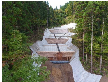
治山施設での木材使用事例 【木製残存型柵（山腹工）】 (宮城北部署：宮城県栗原市)
