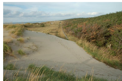
被害対策 【海岸作業道の補修】 (庄内署：山形県鶴岡市湯野浜)
