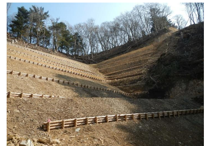
林道施設での木材使用事例 【丸太柵工（林道のり面）】 (宮城北部署：宮城県石巻市)
