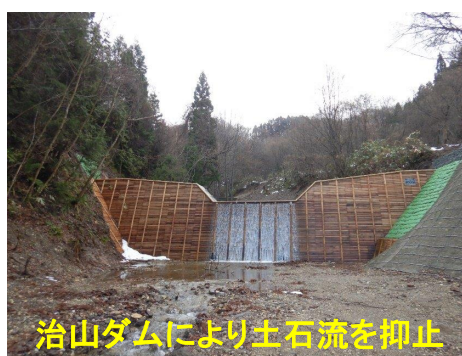
R4.8月の大雨による災害の復旧状況 (津軽署：青森県深浦町)
