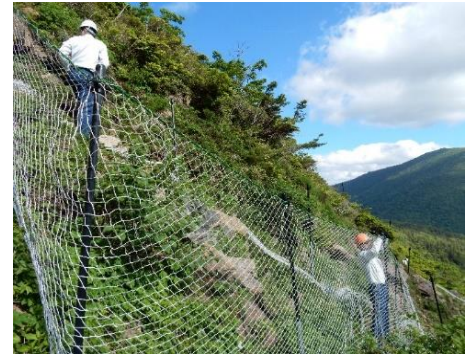
早池峰山での植生保護柵の設置 (三陸北部署：岩手県宮古市)
