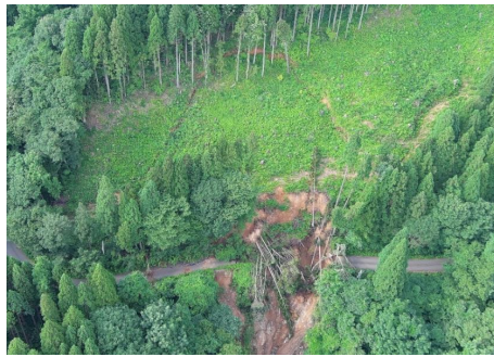
ドローンを活用した被災状況調査 (秋田署：秋田県秋田市)
