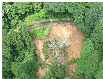
林道の被害状況（谷地の沢林道） (米代西部署：秋田県三種町)
