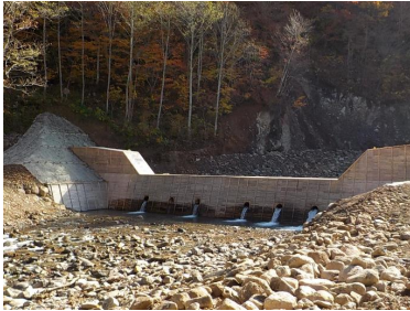
治山事業への木材の利用 (岩手北部署：岩手県八幡平市)
