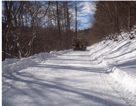
捕獲支援のための林道除雪 (遠野支署：岩手県遠野市)
