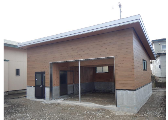
CLTを使用した深浦森林事務所の車庫 (津軽署：青森県深浦町)
