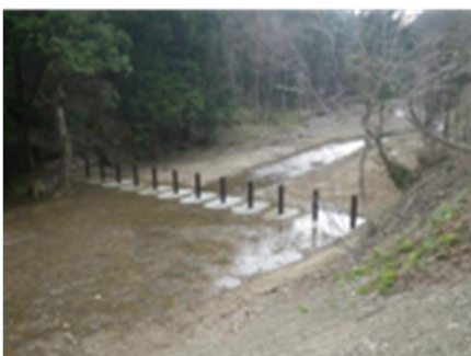
流木対策 (独立基礎型流木捕捉工) (青森署：青森県外ヶ浜町)
