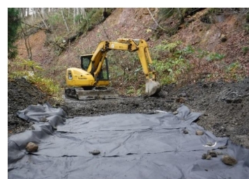
東北式シート工法 (軸掘れ軽減対策) (盛岡署：岩手県雫石町)
