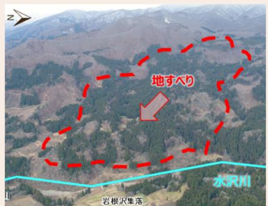
上小沼地区地すべり（全景） (局治山課：山形県西川町)
