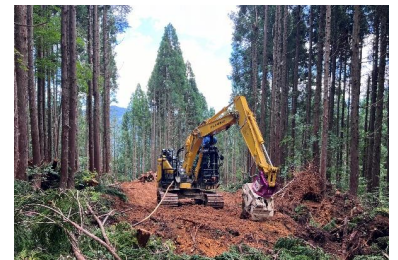
森林作業道の作設
