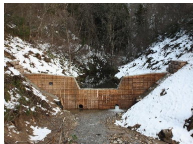
土砂流出対策（溪間工） (置賜署：山形県小国町)
