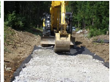
東北式シート工法（轍掘れ軽減対策） (下北署：青森県むつ市)
