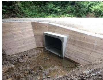
排水施設の強化 (米代東部署：秋田県北秋田市)
