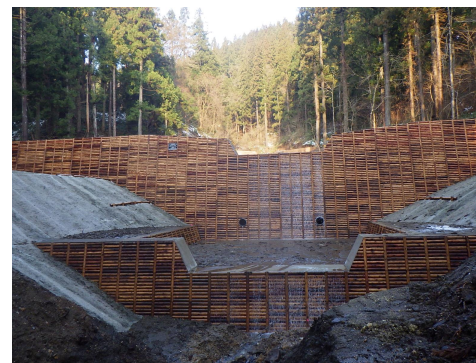
木製残存型枠を使用した治山ダム (米代西部署：秋田県五城目町)
