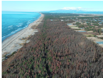
庄内海岸クロマツ林の松くい虫被害 (庄内署：山形県鶴岡市)
