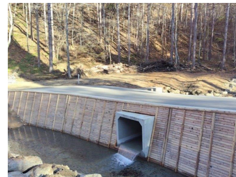
木製残存型枠を使用した林道 (盛岡署：岩手県盛岡市)
