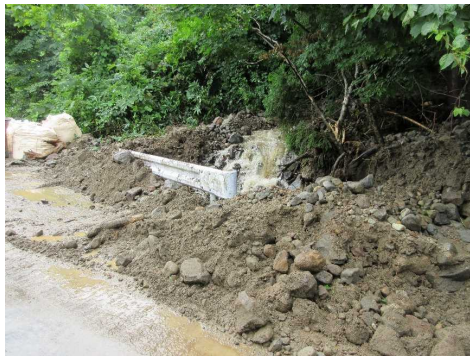
大雨による土砂等の流出 (青森署：青森県今別町)
