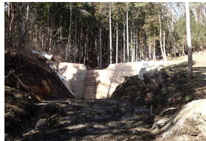
治山事業の木材の利用 【木製残存型枠（治山ダム）】 (仙台署：宮城県丸森町)
