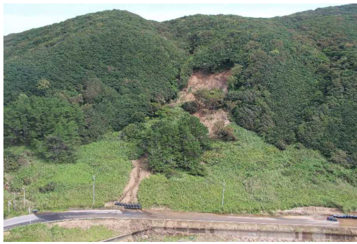
大雨による山腹崩壊 (金木支署：青森県五所川原市)
