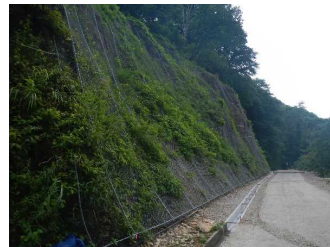
覆式落石防護網工 (秋田署：秋田県美郷町)
