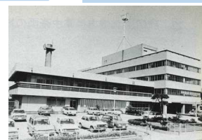
昭和38年竣工（現在も使用）
