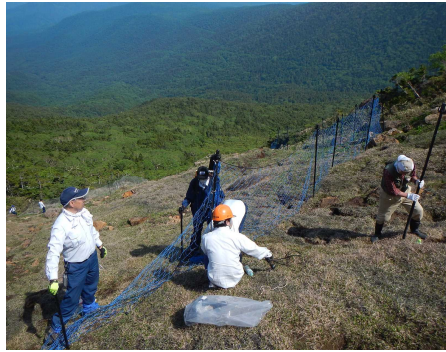
早池峰山での植生保護柵の設置 (三陸北部署：岩手県宮古市)
