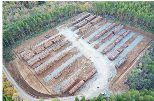
トレーラーへの効率的積込や丸太の大量保管ができるストックヤード (岩手北部署：八幡平市)
