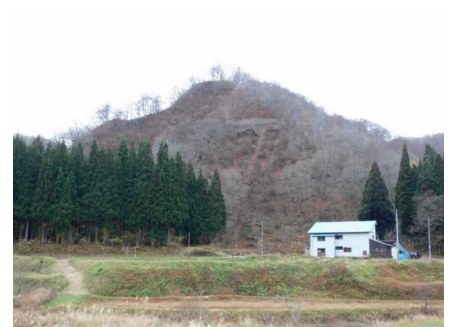
なだれ予防対策(スノーネット工) (由利署：秋田県由利本荘市)
