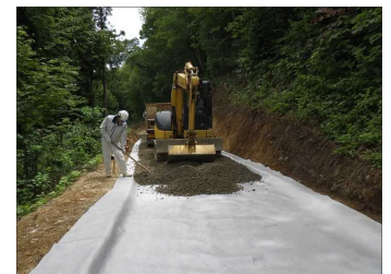
東北式シート工法(軸掘れ軽減対策) (岩手南部署：岩手県花巻市)
