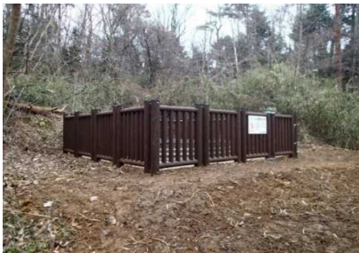
治山事業の木材の利用 【集水井用安全柵】 (仙台署：宮城県仙台市)
