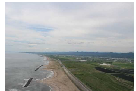
海岸防災林の森林整備事業 【ボランティアによる保育】 (宮城北部署・仙台署：宮城県東松島市、山元町)
