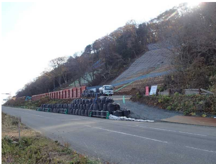
下風呂(1) 災害関連緊急治山工事 【令和3年台風9号】 (下北署：青森県風間浦村)
