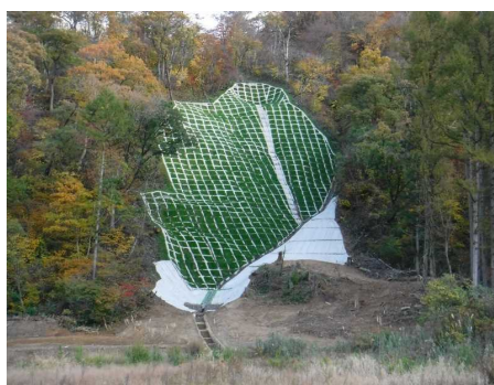
山腹工 (最上支署：山形県戸沢村)
