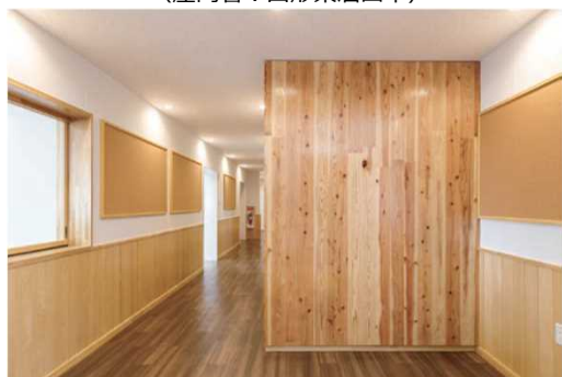
令和3年度に新築した森林技術・支援センター、金木支署中里森林事務所（青森県中泊町） 左：廊下・展示コーナー（化粧壁はスギCLT）
