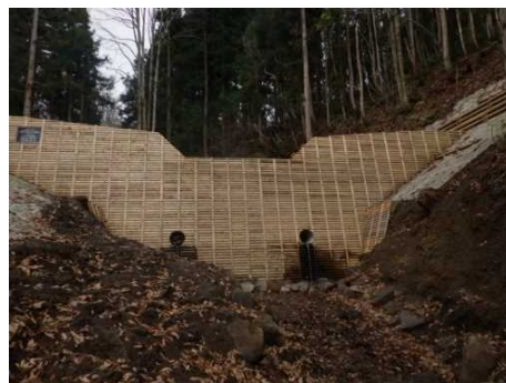
蔵王温泉地区災害関連緊急治山工事 【令和元年東日本台風】(山形県山形市)
