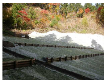
治山事業の木材の利用 【山腹工の木柵工】 （宮城北部署：宮城県栗原市）
