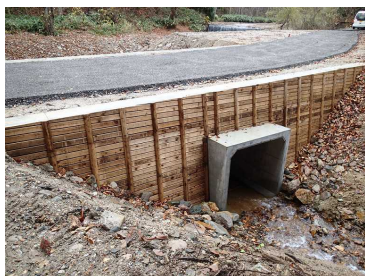
林道事業への木材の利用 左：木製型枠（湯沢支署：秋田県湯沢市）
