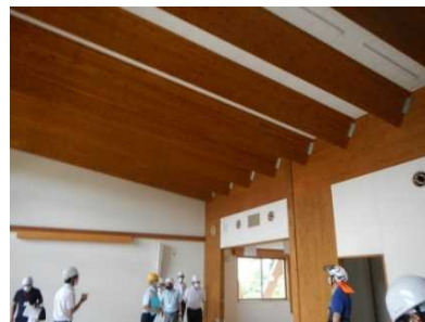
CLT建築状況見学会 （宮城北部署：宮城県大衡村）
