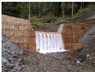
治山事業への木材の利用 木製残存型枠を使用した床固工 (庄内署：山形県酒田市)
