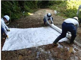
東北式シート工法 (轍掘れ軽減対策) (湯沢支署：秋田県湯沢市)
