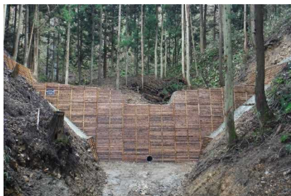
コンクリート谷止工への木材利用 (秋田署：秋田県秋田市)
