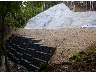
大型かご砕工・モルタル吹付工 (宮城北部署：宮城県栗原市)
