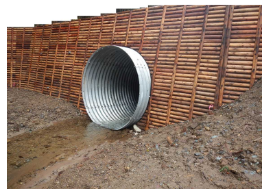
右：木製型枠（米代東部署：秋田県大館市）
