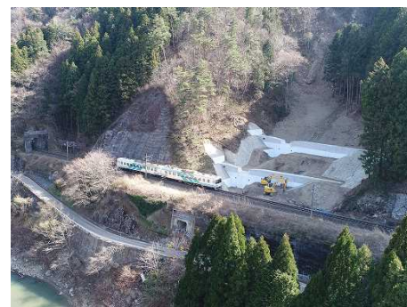
小塚山5号災害復旧工事 【令和元年東日本台風】(宮城県丸森町)
