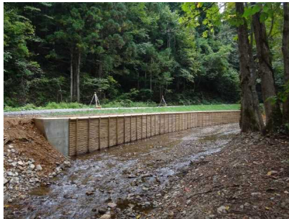
木製残存型柵を使用した林道擁壁工事 （岩手南部署：岩手県西和賀町）
