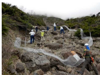
早池峰山での植生保護柵の設置 (遠野支署：岩手県花巻市)
