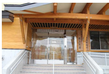
庁舎への木材利用 (最上支署：山形県真室川町)
