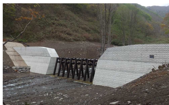
鋼製スリットダム (津軽署：青森県弘前市)
