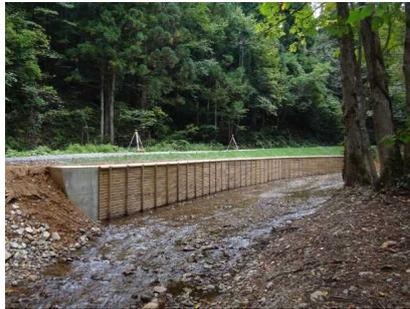
木製残存型枠を使用した林道擁壁工事
