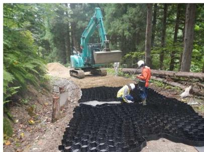
路盤補強工法（轍掘れ軽減対策）
