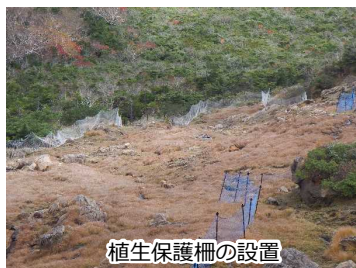
植生保護柵の設置 (宮古市：三陸北部署管内)
