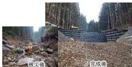
白浜地区治山工事（宮古市：三陸北部署管内）
