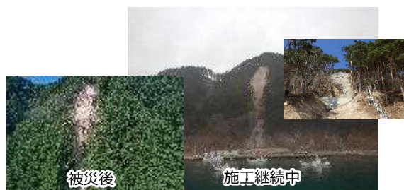
久喜地区治山工事（久慈市：久慈支署管内）
