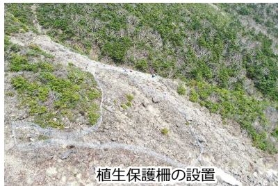
植生保護柵の設置 (遠野市：遠野支署管内)
