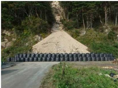
応急対策：土砂撤去、大型土のう設置
