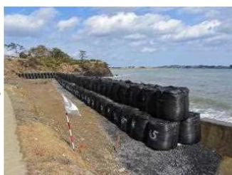
大型土のうによる仮設護岸工
