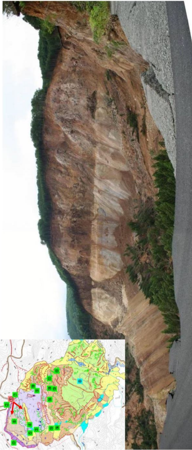
2008年地すべり発生直後(①：滑落崖：崩落した市道の直上部から)
