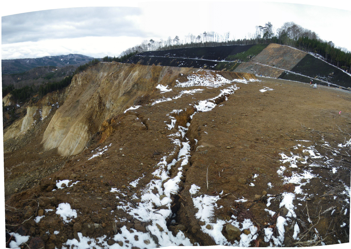
写真 4.2.4(④) 排土面縁辺部に発生した亀裂
