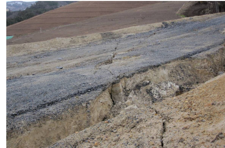
写真 4. 2.16 (⑤) 法面に隣接する作業道の亀裂
