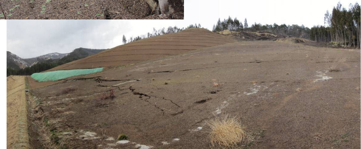
写真 4. 2.15 (④) 末端部山腹工法面に生じた亀裂(上は亀裂の近景)
