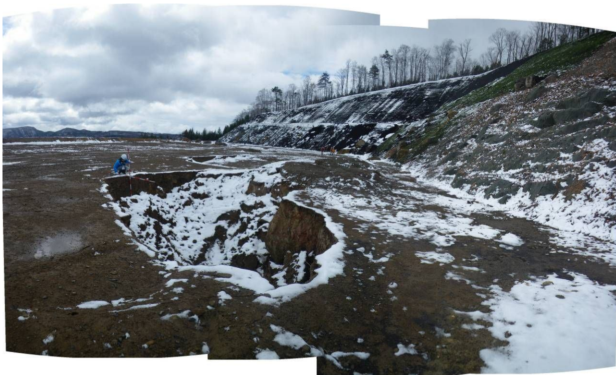
写真 4.2.3(③) 排土面に発生した亀裂 陥没地形
