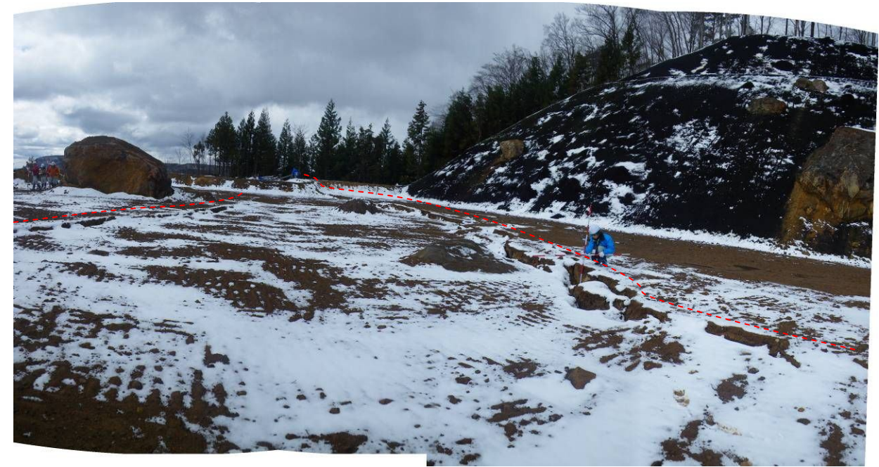
写真 4.2.1(①) 排土工上面に発生した亀裂
