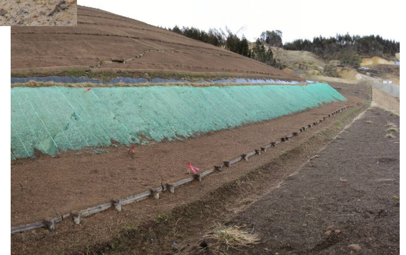
写真 4. 2.17 法面上部に生じた亀裂
