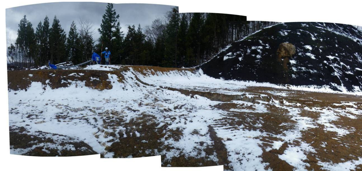
写真 4.2.2(②) 排土工上面に発生した亀裂 地表伸縮計 S-3 が破損
