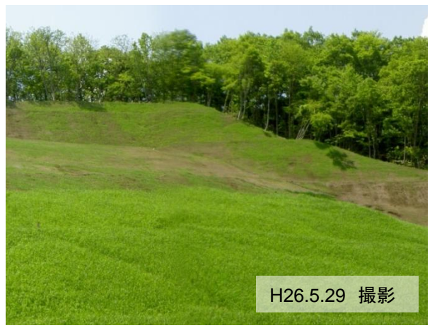
ニゴリ沢第四工区 [地すべり防止工事]
