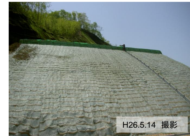
ニゴリ沢第一工区 [地すべり防止工事]
