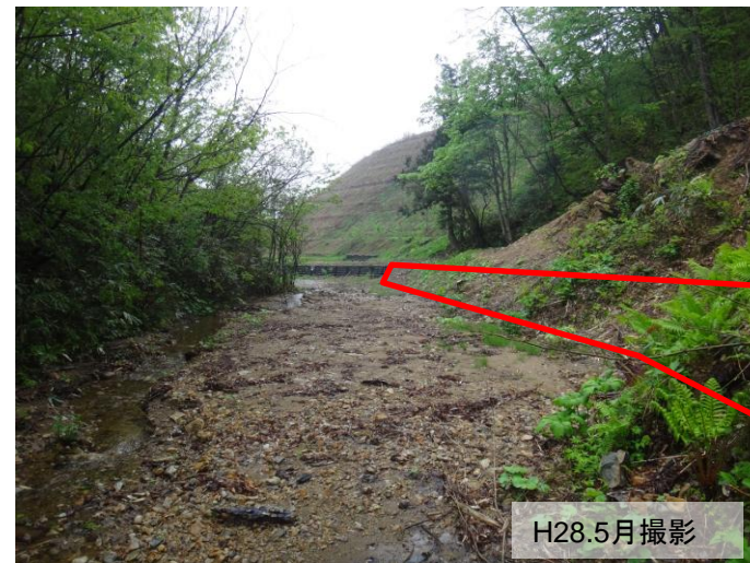
現況 上流より
