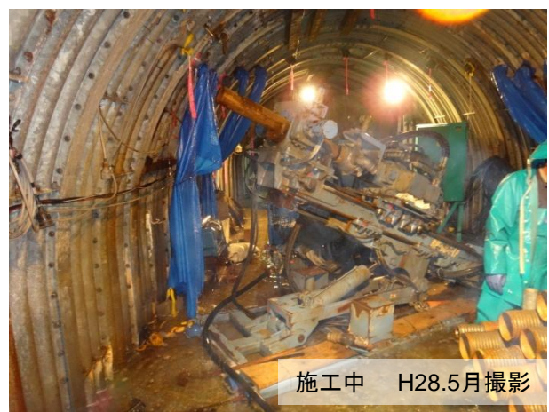
小股沢排水トンネル補修 [地すべり防止工事]
