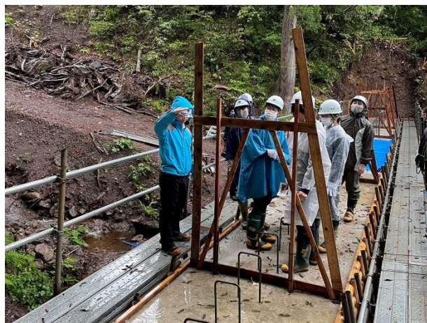
治山ダムの説明を行う村井監督員
