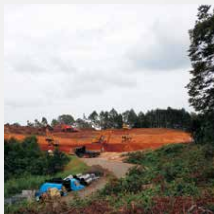
建設中の山葵沢地熱発電所
