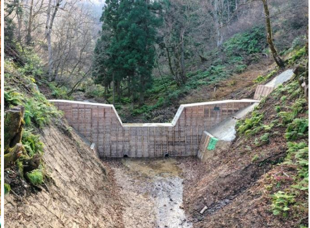
コンクリートダム工 (令和4年度 虫内沢)
