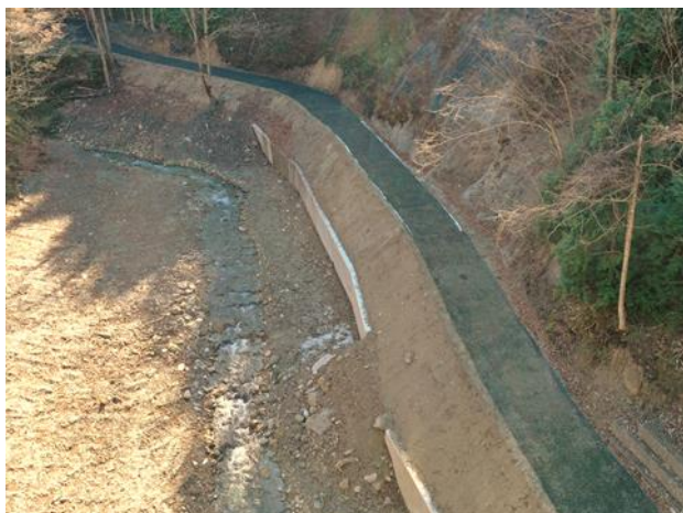
令和4年度 奥赤倉沢林道新設工事 完成写真
