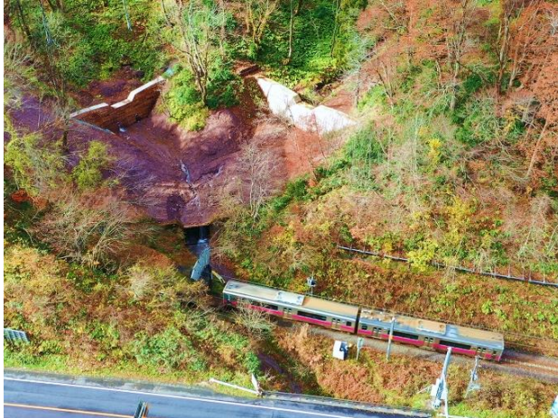
コンクリートダム工 (令和4年度 峠の沢)
