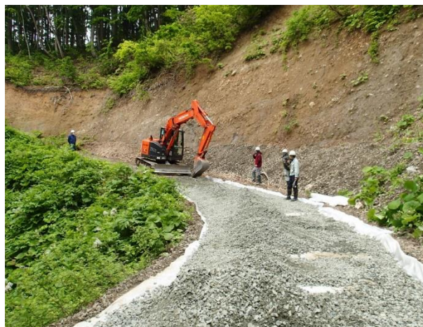
プロジェクトチームによる 「東北式シート工法」
