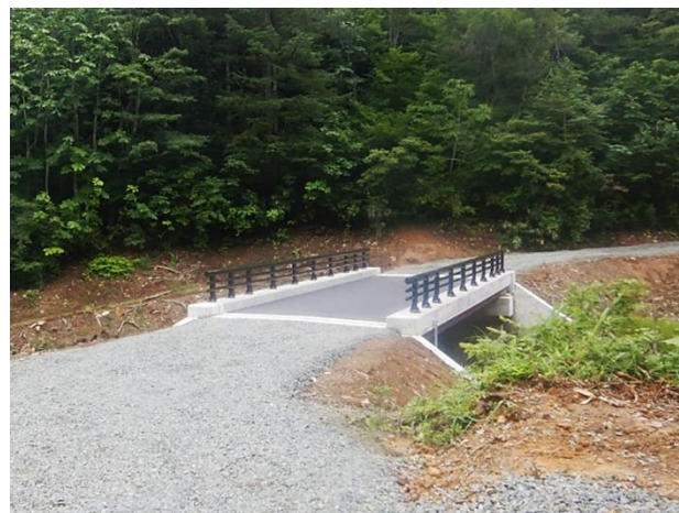
令和4年度 小仁郷林道改良工事 完成写真
