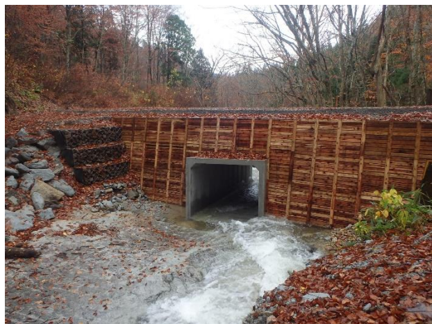
令和3年度 湯の又林道改良工事 完成写真
