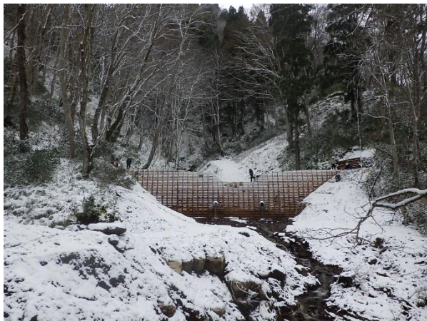
コンクリートダム工 (令和3年度 峠の沢)
