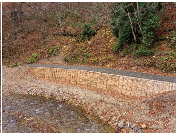
令和3年度 奥赤倉沢林道(林業専用道) 新設工事 完成写真
