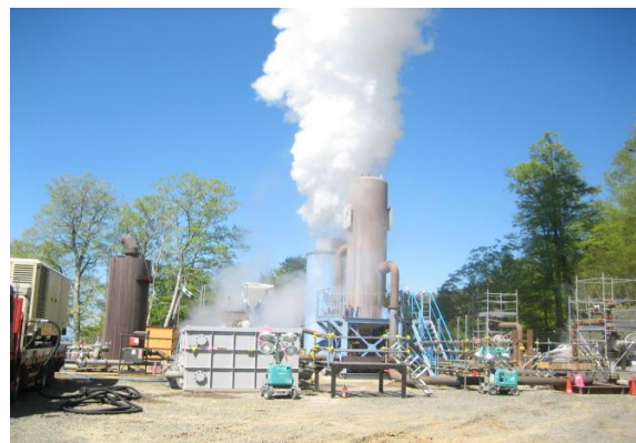
施設建設中の山葵沢地熱発電
