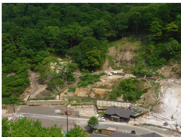
泥湯温泉の施工地
