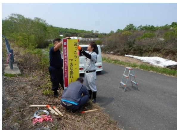
入山禁止看板等設置
