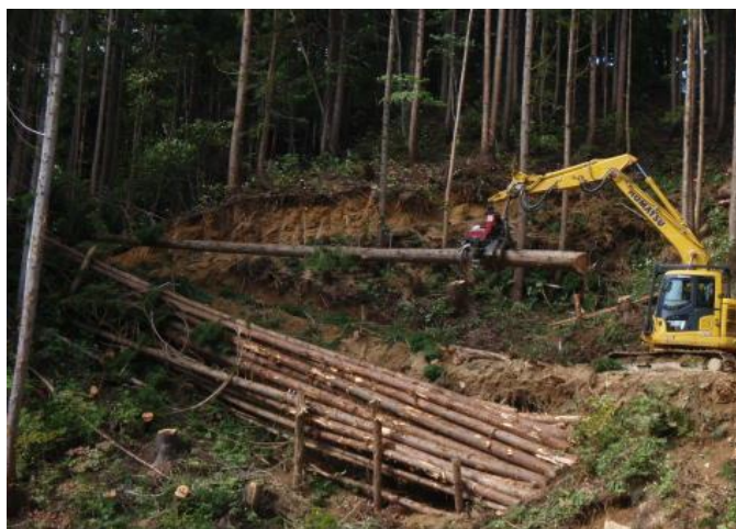
林業機械による造材作業
