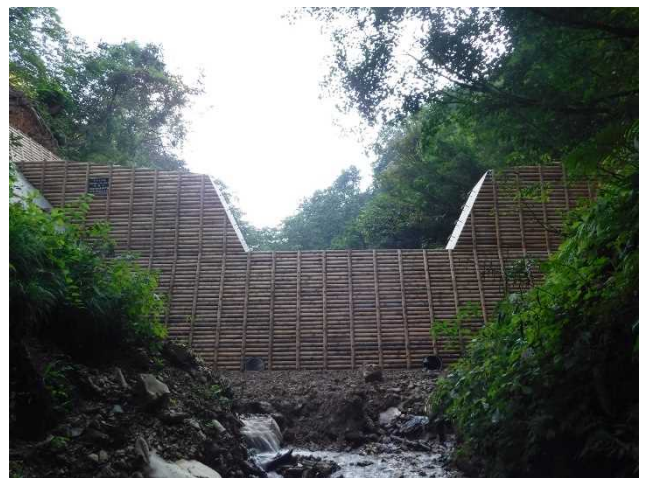
コンクリート谷止工（令和元年度 虫内沢）
