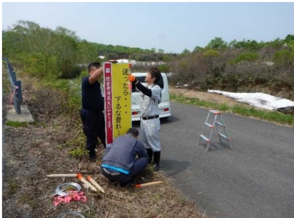
入山禁止看板等設置
