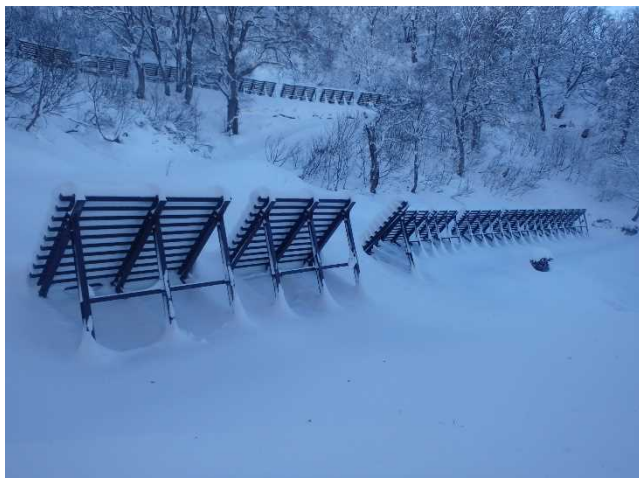
雪崩予防柵工（令和元年度 泥湯温泉第二）
