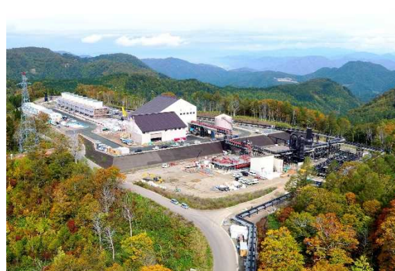
山葵沢地熱発電所
