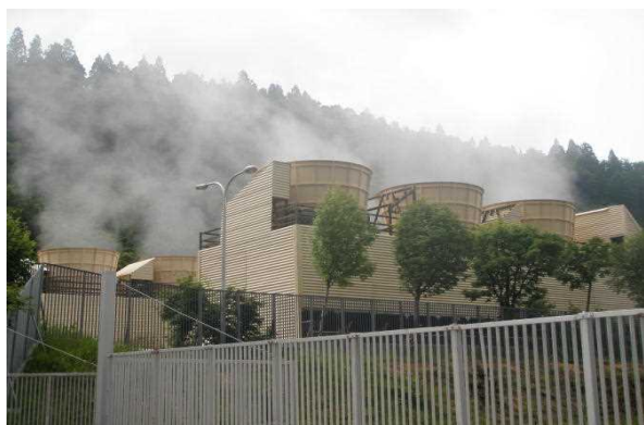
上の岱地熱発電所
