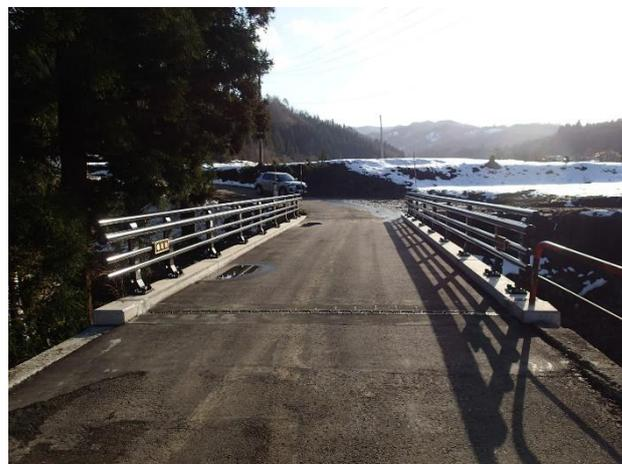
蟻坂橋補修工事（幅員 4.0m、延長 14.4 m）
