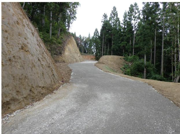
下松倉新設工事（幅員 3.6m、延長 230m）
