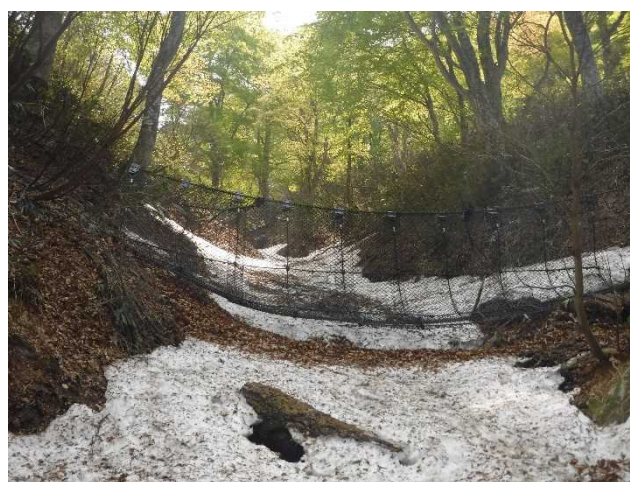
なだれ予防ネット工
