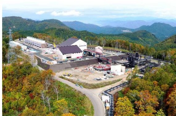
山葵沢地熱発電所
