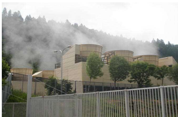
上の岱地熱発電所
