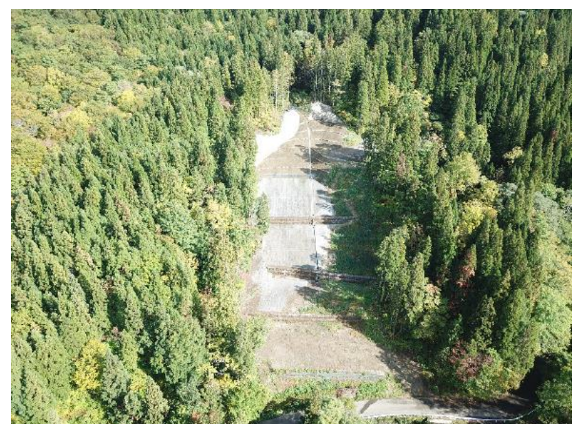
施行後(石禿沢施設災害復旧工事)
