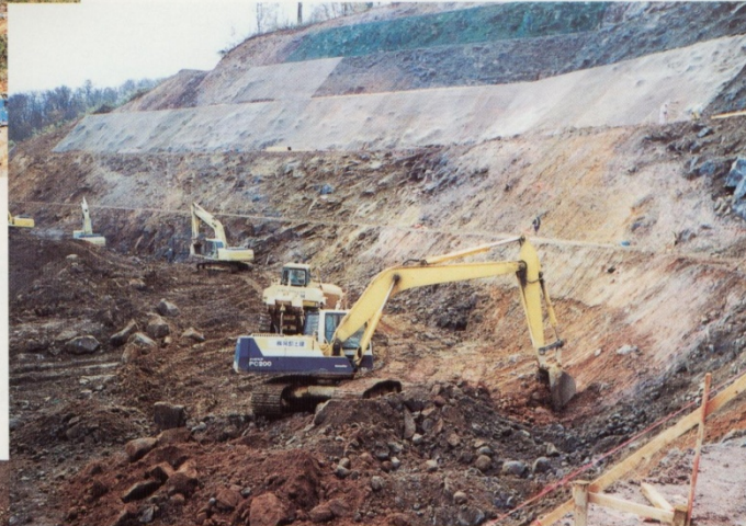
排土工：地山掘削状況
