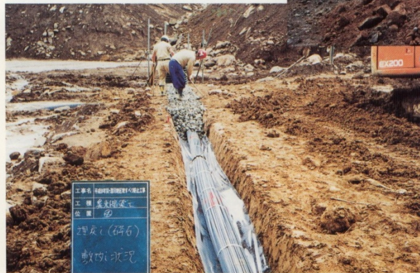
集束暗渠工：Sドレーン埋設状況
