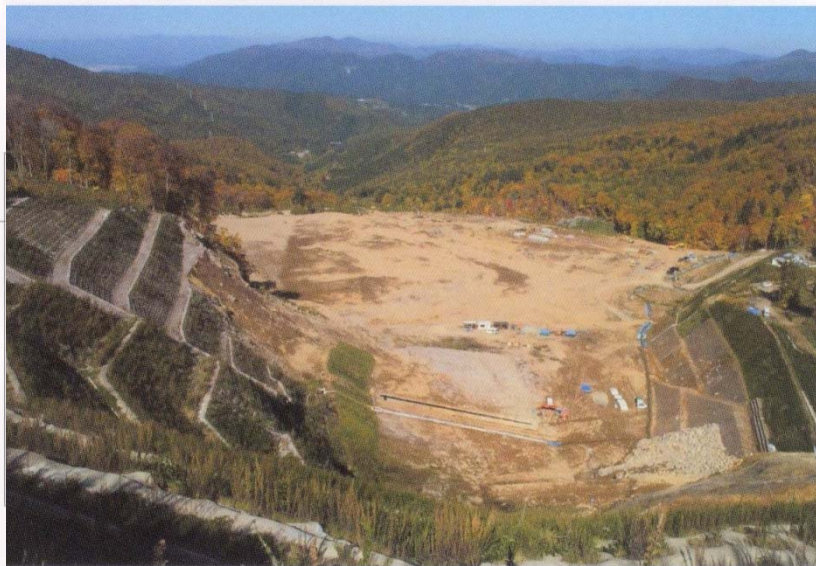
排土工完了後の状況
