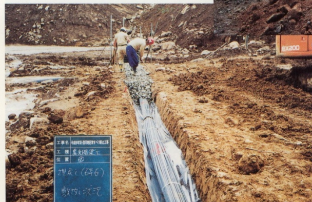
集束暗渠工：Sドレーン埋設状況
