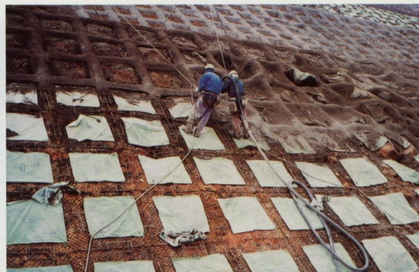
緑化法砕工：モルタル吹付状況
