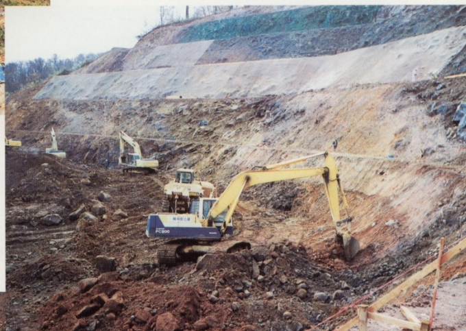
排土工：地山掘削状況
