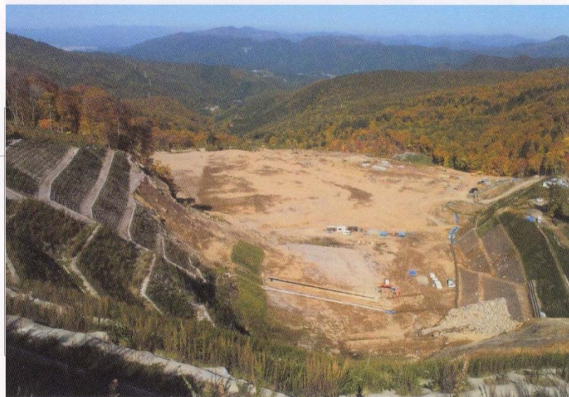
排土工完了後の状況
