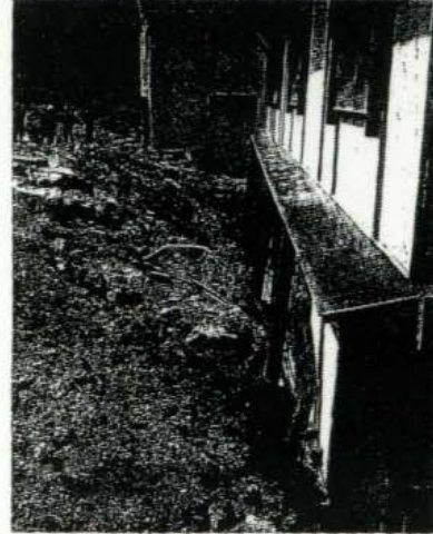
地滑りがあった澄川温泉。裏山(右手前)に土砂が押し寄せ、地盤がさしむきになり、建物も破損した。土砂は道路と、温泉街方面に約2kmにわたって(鹿角市八幡平)。
