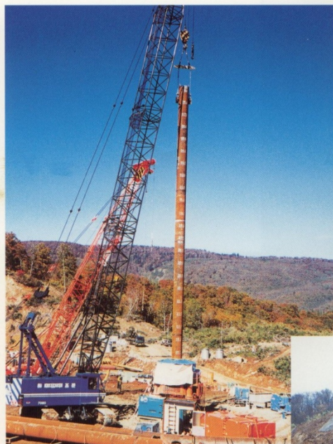
鋼管シャフト杭打工：鋼管建込状況
