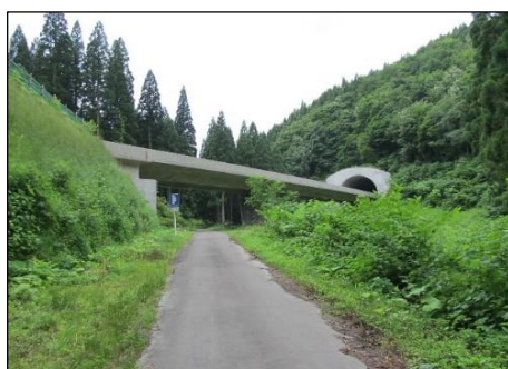
日本海沿岸東北道の建設（大館市）
