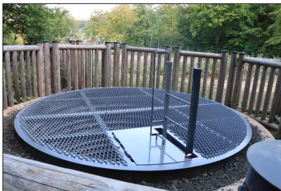
地すべり対策で施工した集水井（鹿角市）
