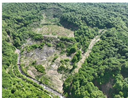
澄川・赤川温泉地すべり災害跡地の現況（鹿角市）
