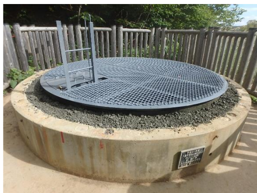
地すべり対策で施工した集水井（鹿角市）
