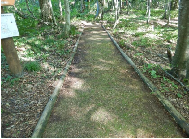
作業後の遊歩道（1）
