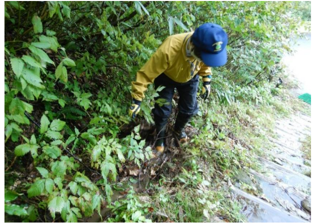
登山道入口での排水作業（2）
