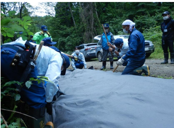
遮光シートの設置
