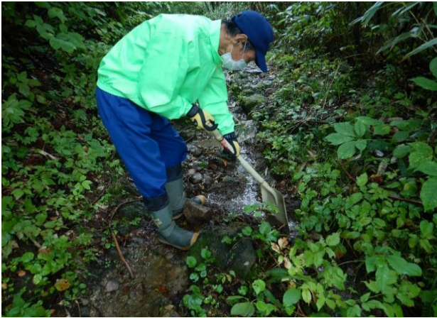
登山道入口での排水作業（1）
