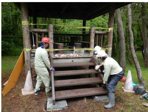
【写真上：階段を設置】
