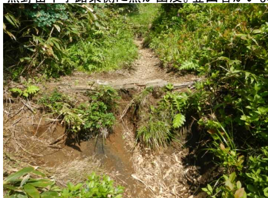
段差が大きく歩行しにくいいため片側を少し掘り崩しました。
