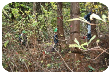
◎プロット伐採作業状況写真
