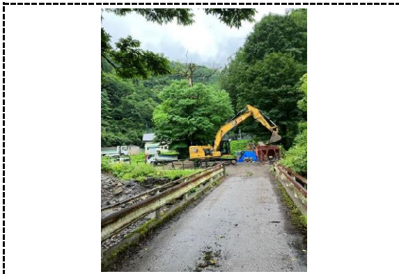
8月8日 笹内川築堤取付道外巡視 場所：笹内川築堤
