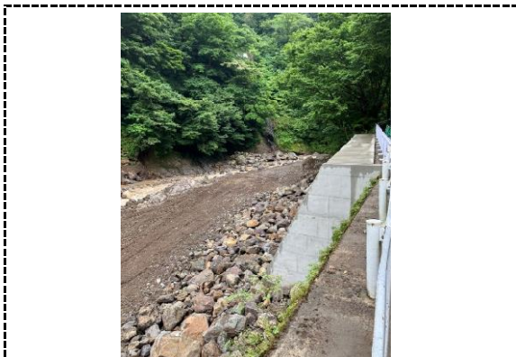
8月8日 白神ライン笹内川上流部復旧状況確認 場所：笹内川上流部
