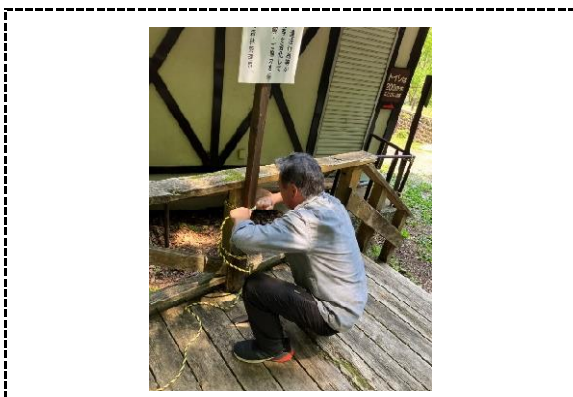
6月20日 暗門の滝入口幟旗設置 場所：暗門の滝入口
