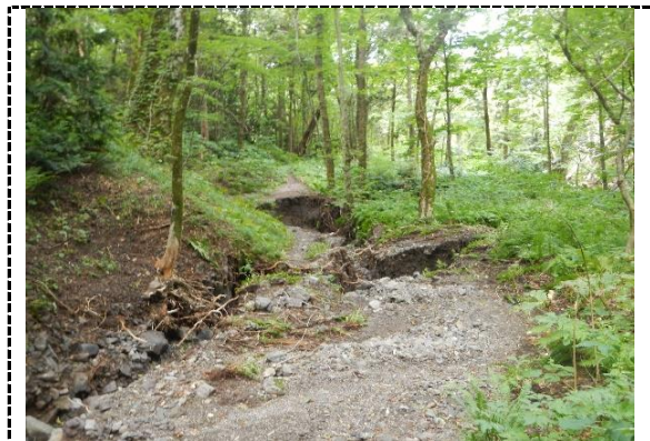
8月26日 崩れ山登山道点検 場所：崩れ山登山道
