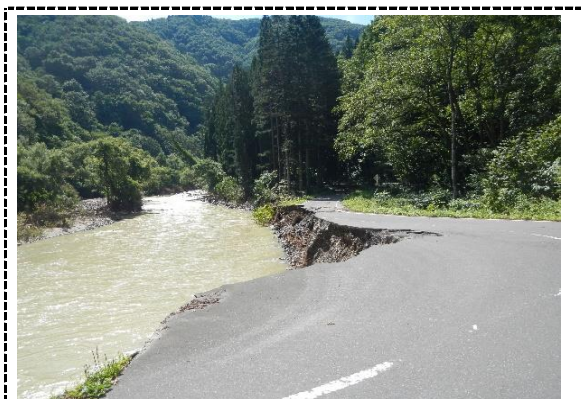
8月22日 赤石溪流線点検 場所：赤石溪流線ゲート奥
