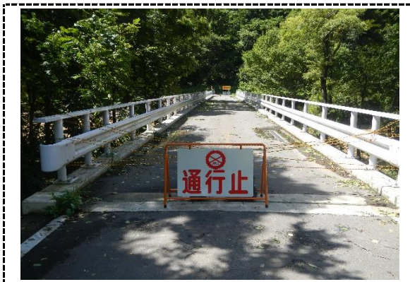
8月17日 赤石溪流線点検 場所：赤石溪流線ゲート奥
