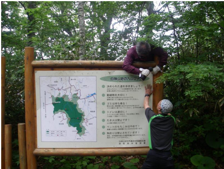
◎6月22日 太夫峰にある看板を修理して いるところです。
