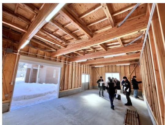
【倉庫内部に構造材を採用】
