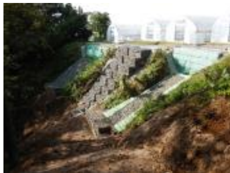
寒水沢治山工事
