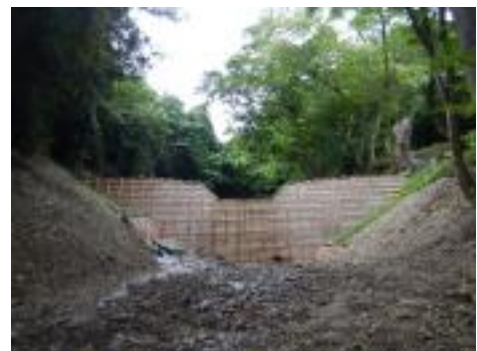
間伐材を利用した治山工事
