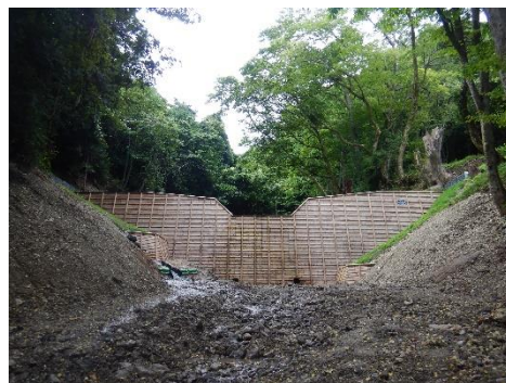
間伐材を利用した治山工事
