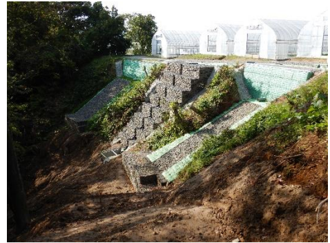
寒水沢治山工事
