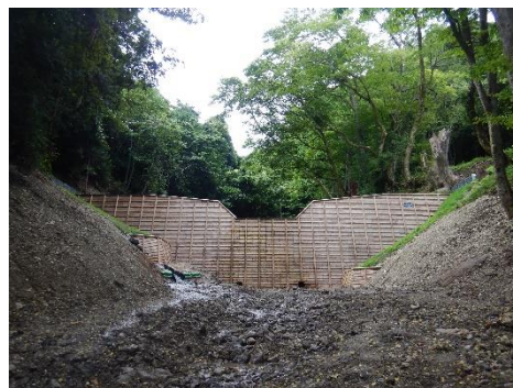
間伐材を利用した治山工事
