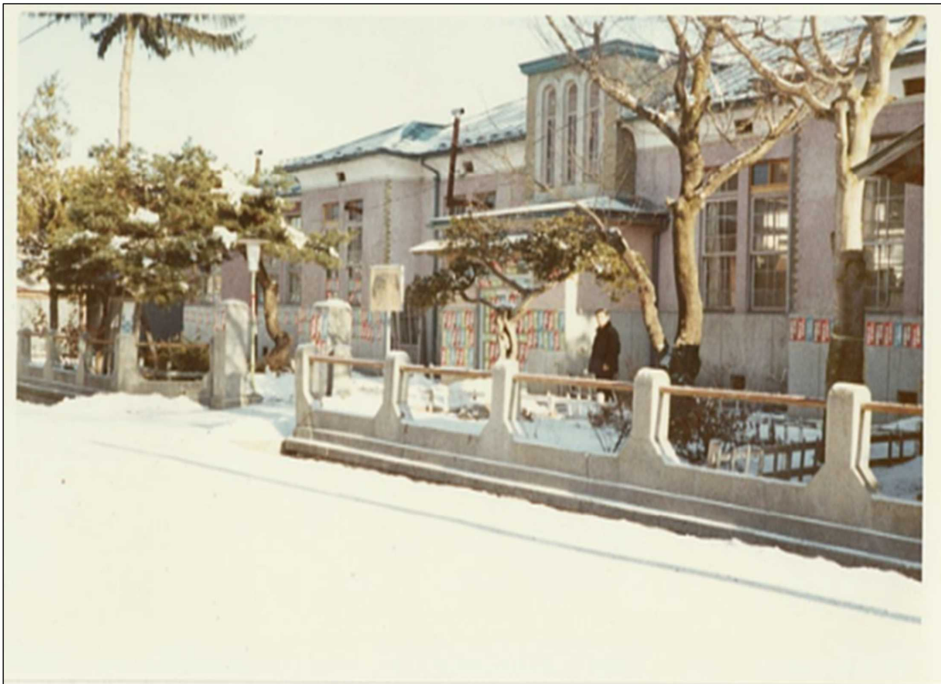
4 昭和49年の旧東館町庁舎（石倉丁庁舎） 建物は現在より道路側にあり、壁には労働組合活動のビラが貼られている。
