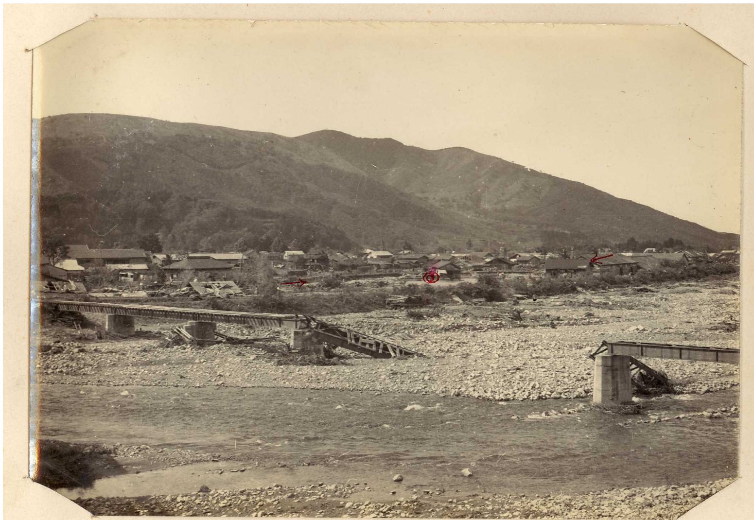
遠野貯木場附近早瀬川の軌道橋プレートガーター
