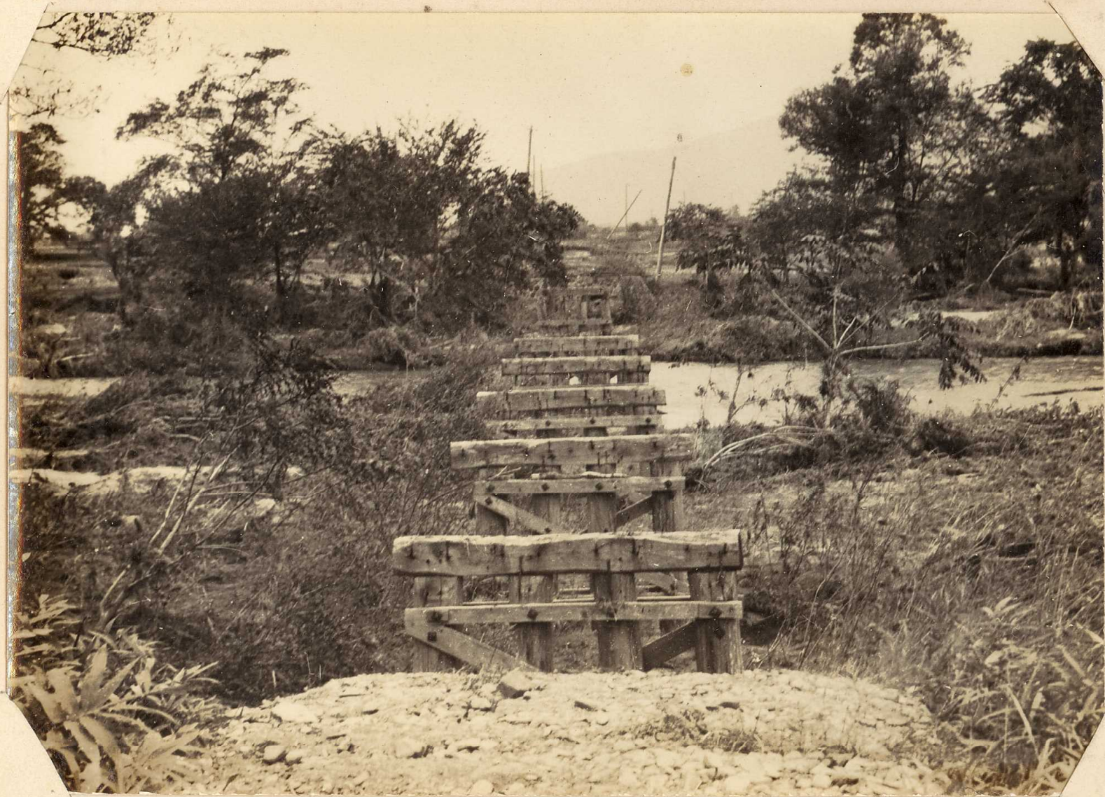
左岸(海上集落)側から撮影 小鳥瀬川橋梁
