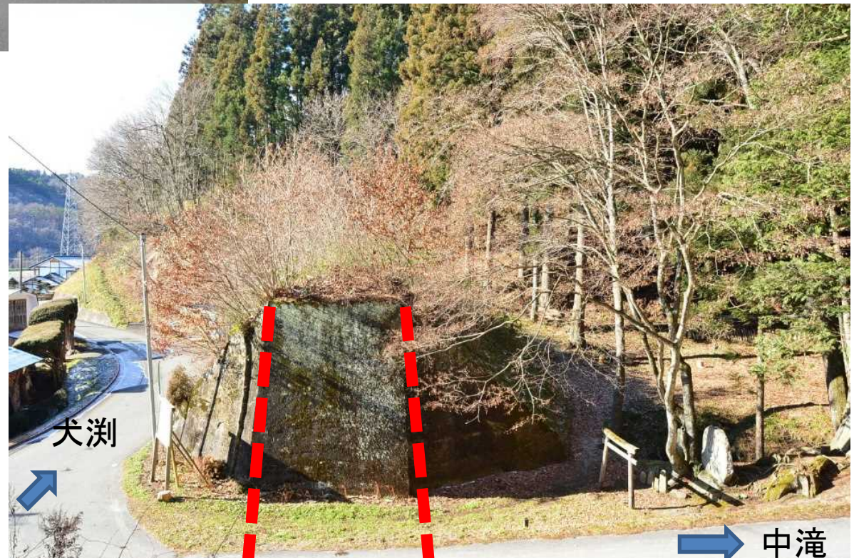
附馬牛町和野 (コンクリート橋台跡)
