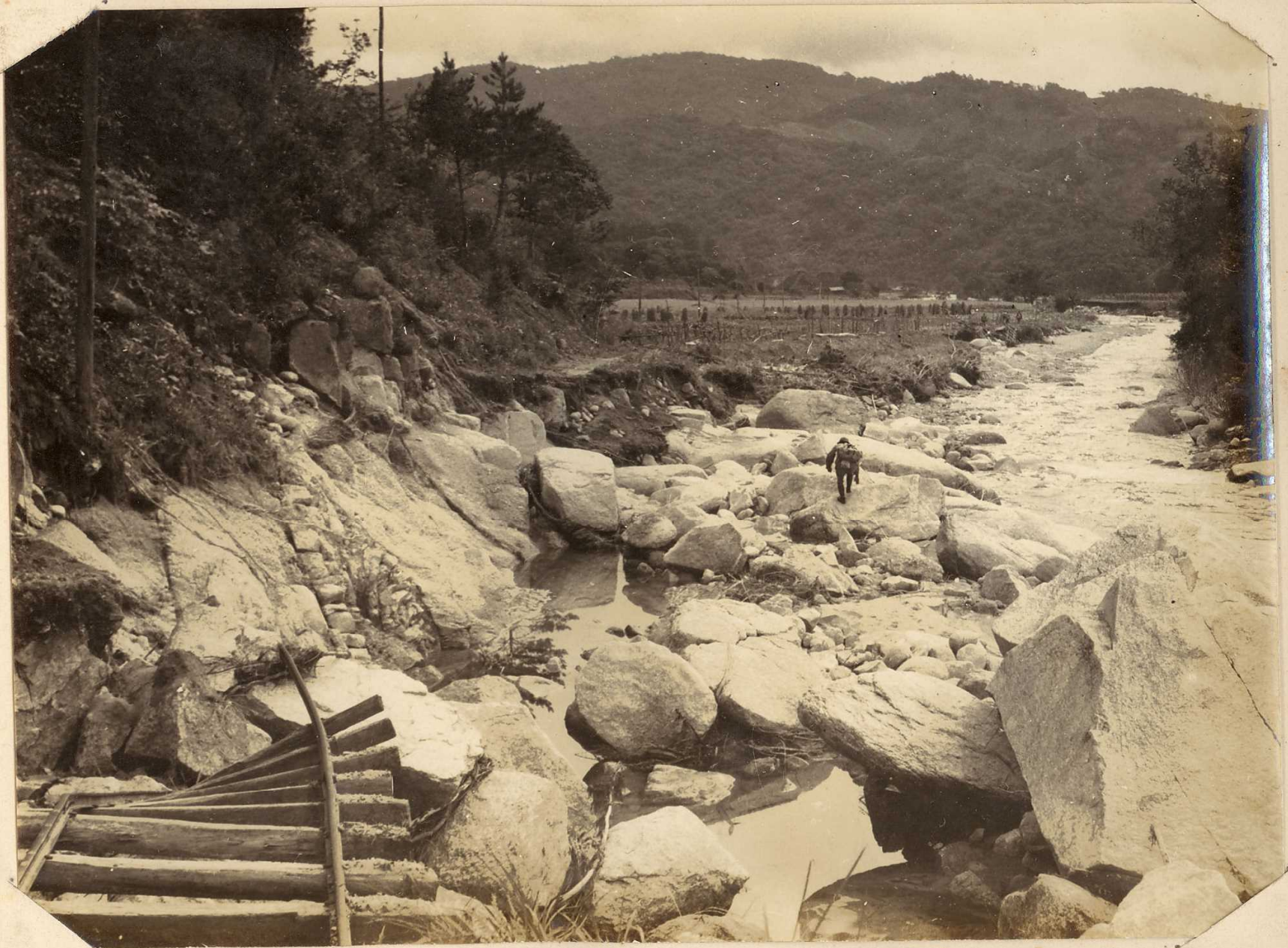
「遠野営林署管内水害状況写真」青森営林局(1948)より
