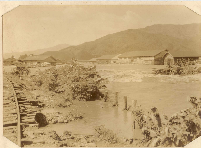
旧釜石線と水没した貯木場
