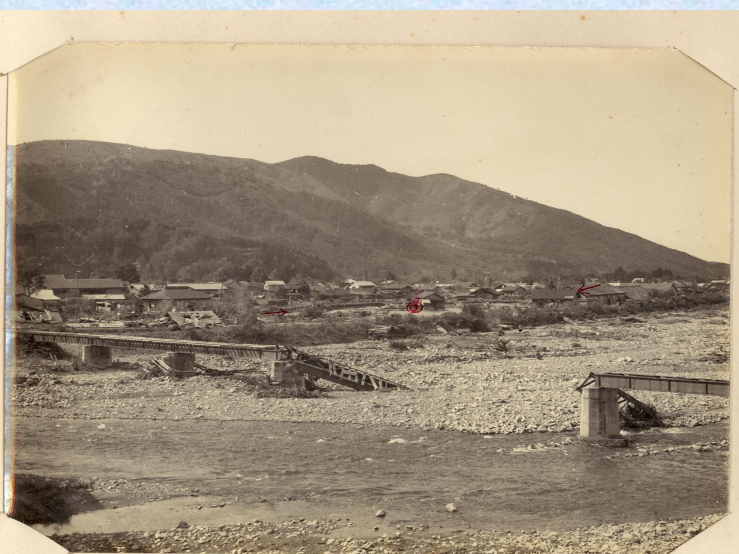
流出した森林鉄道の橋梁
