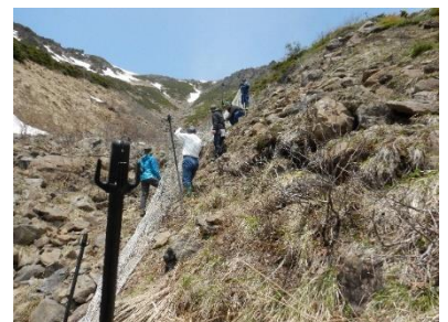
・保護柵設置作業中
