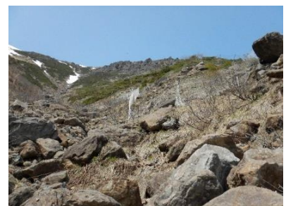
・保護柵設置完了
